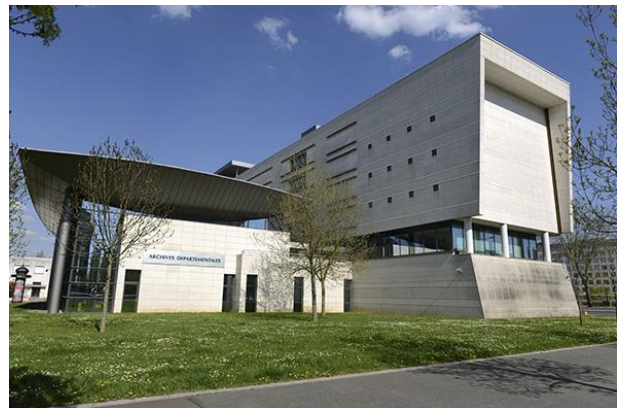
FIGURE 1. LE BATIMENT DES ARCHIVES DEPARTEMENTALES DES YVELINES A MONTIGNY-LE-BRETONNEUX
